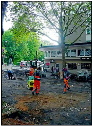
Arbeiter samt Geräten an der Koblenzer Straße. FOTO: JACOB
