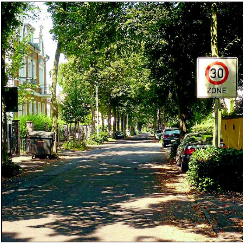
Von sechs auf fünf Meter will die Stadt die Fahrbahn der Herderstraße verengen. FOTO: GLOCK
